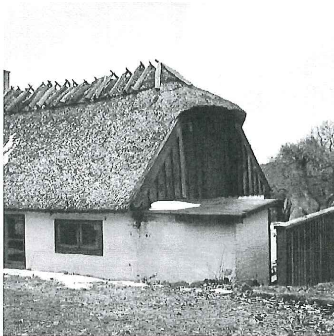
Eksisterende port i gavl udskiftes med glassdør svarende til husets øvrige glaspartier.
