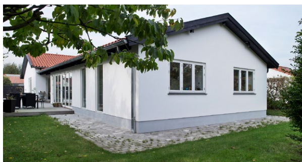
Kongestien 56, Virum er opført 1947. Billedet viser tilbygning fra 2017 mod haven og det oprindelige lille statslåns hus med det røde tegltag ligger mod vejen. Tilbygningen er opført i et moderne formsprog, samtidig med at den respekterer det originale hus. Et godt eksempel på, at man kan bevare de ældre, små boliger, samtidig med at nutidens behov for mere plads opfyldes. Huset er en del af en samlet bebyggelse med 76 huse tegnet af Mogens Lassen.
