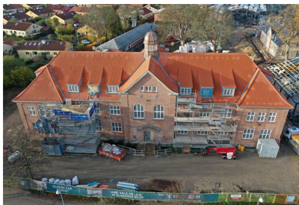
Kongevejen 79 i Sorgenfri blev opført i 1916 som landbrugsmuseum. Kommunen købte ejendommen i 2015 og solgte den igen 2020. Nu skal ejendommen blandt andet være museum for klassiske biler. En gennemgribende renovering og de nye anvendelser vil give liv til bygningen og området. Samtidigt sikres den meget smukke hovedbygning i mange år fremover.
