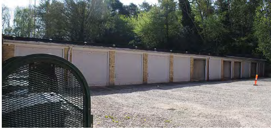
Sydøst for garagerne etableres støjskærm
