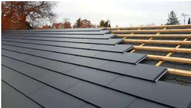
Figur 15 Tagintegrerede solceller. Kilde: solartag.eu
