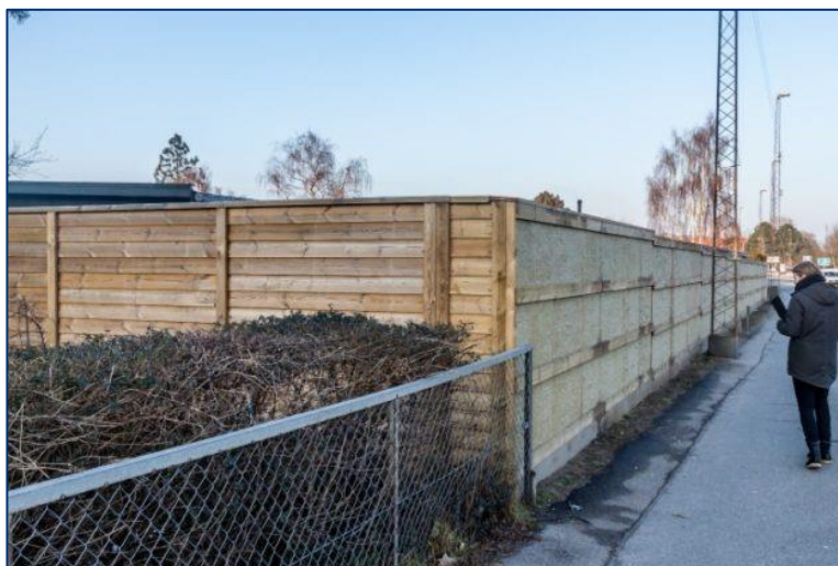
Figur 39. Her har grundejeren bygget sit eget støjhegn og brugt mineraluld på siden mod vejen. Hegnet har formentlig en god støjdæmpende virkning fordi det er tæt, har en god højde og går op i skel vinkelret på vejen. Mineralulden har ingen betydning for hegnets støjdæmpende virkning hos grundejeren.
