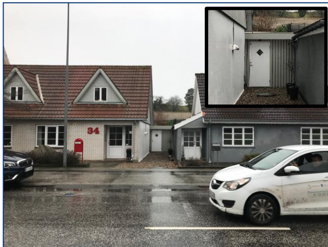
Figur 40. Boligerne skærmer for støjen, men der kommer støj ind gennem smøgen mellem de to huse. Ved at sætte et hegn (her også med en dør) i smøgen, er støjen i baghaven dæmpet mærkbart.
