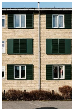
Figur 35. Støjdæmpende multifunktionsvindue (billederne til venstre og i midten). Støjen dæmpes på vejen gennem åbningen for neden (udendørs) til åbningen for oven (indendørs). Til højre er vist en lydskodde, som er monteret foran et eksisterende vindue. Den dæmper støjen, men giver også adgang for frisk luft. Den kan desuden mørkelægge et rum, hvis det ønskes.
