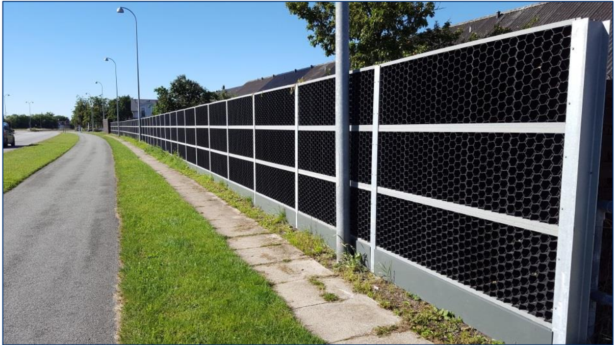
Figur 28. Eksempel på støjskærm langs et boligområde. De sorte akustiske elementer i skærmen består af materiale fra genbrugte vindmøllevinger (eksempel fra Vallensbæk).
