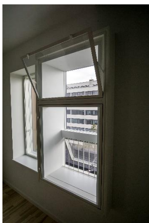
Figur 35. Støjdæmpende multifunktionsvindue (billederne til venstre og i midten). Støjen dæmpes på vejen gennem åbningen for neden (udendørs) til åbningen for oven (indendørs). Til højre er vist en lydskodde, som er monteret foran et eksisterende vindue. Den dæmper støjen, men giver også adgang for frisk luft. Den kan desuden mørkelægge et rum, hvis det ønskes.
