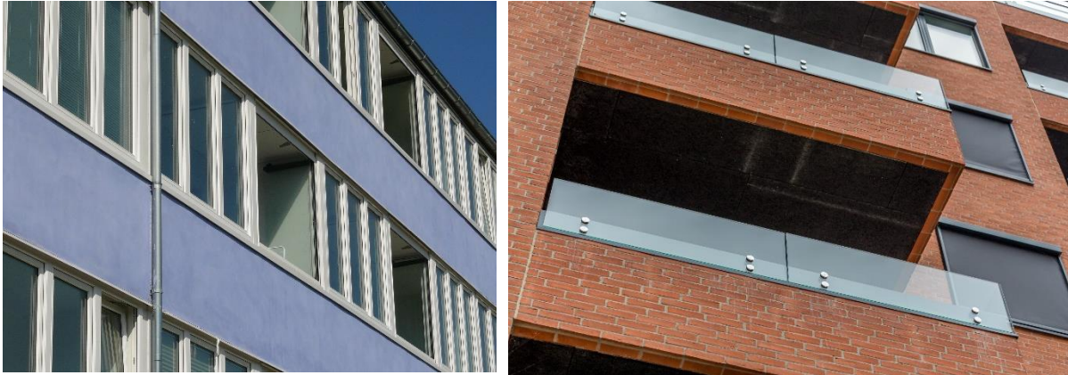
Figur 36. I ejendommen til venstre blev altanerne forsynet med en forsatsrude, der kan skydes til siden. Når ruden er lukket, fungerer den sammen med altanrummet som en meget effektiv støj dæmpning. Til højre er vist åbne altaner med en glasafskærmning, der begrænser støjen. Der er desuden et lydabsorberende akustikloft, som dæmper støjen i altanrummet.
