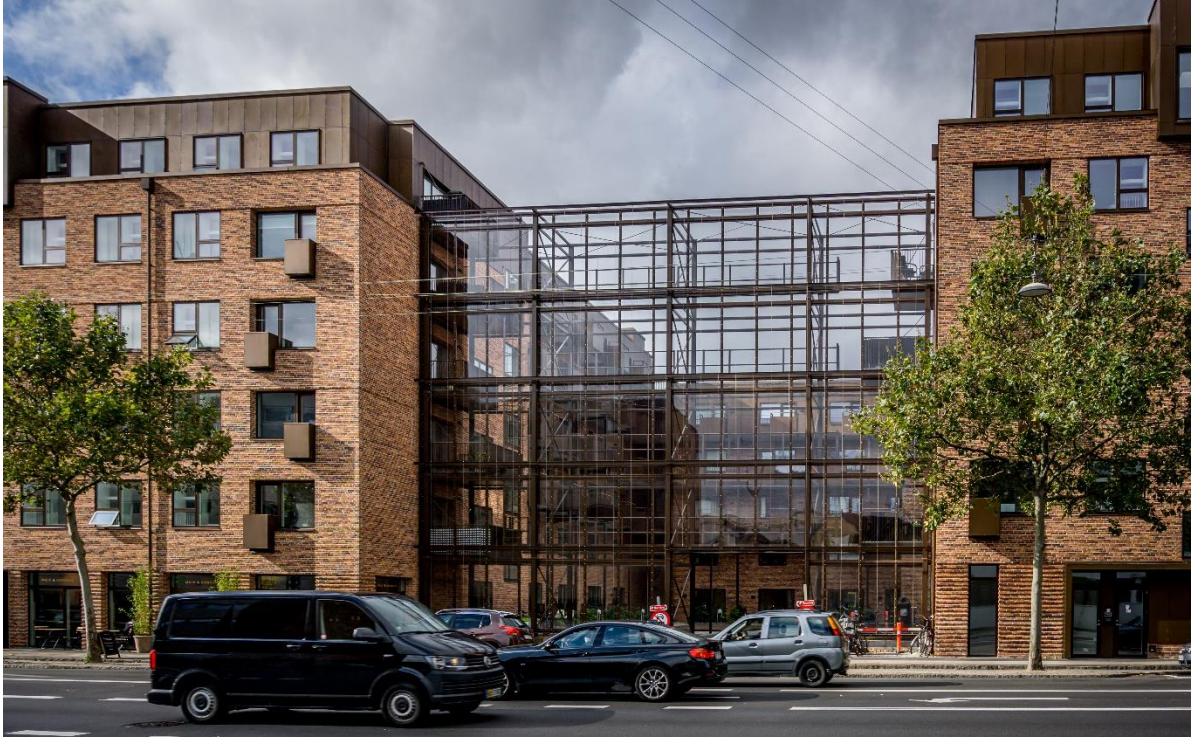
Figur 34. I denne nye bebyggelse, har man anvendt en støjskærm i åbningen mellem bygningerne for at opnå et lavt støjniveau i bebyggelsens gårdmiljø. I facaden mod vejen er der anvendt særligt støjdæmpende vinduesløsninger (Gl. Køge Landevej, København).
