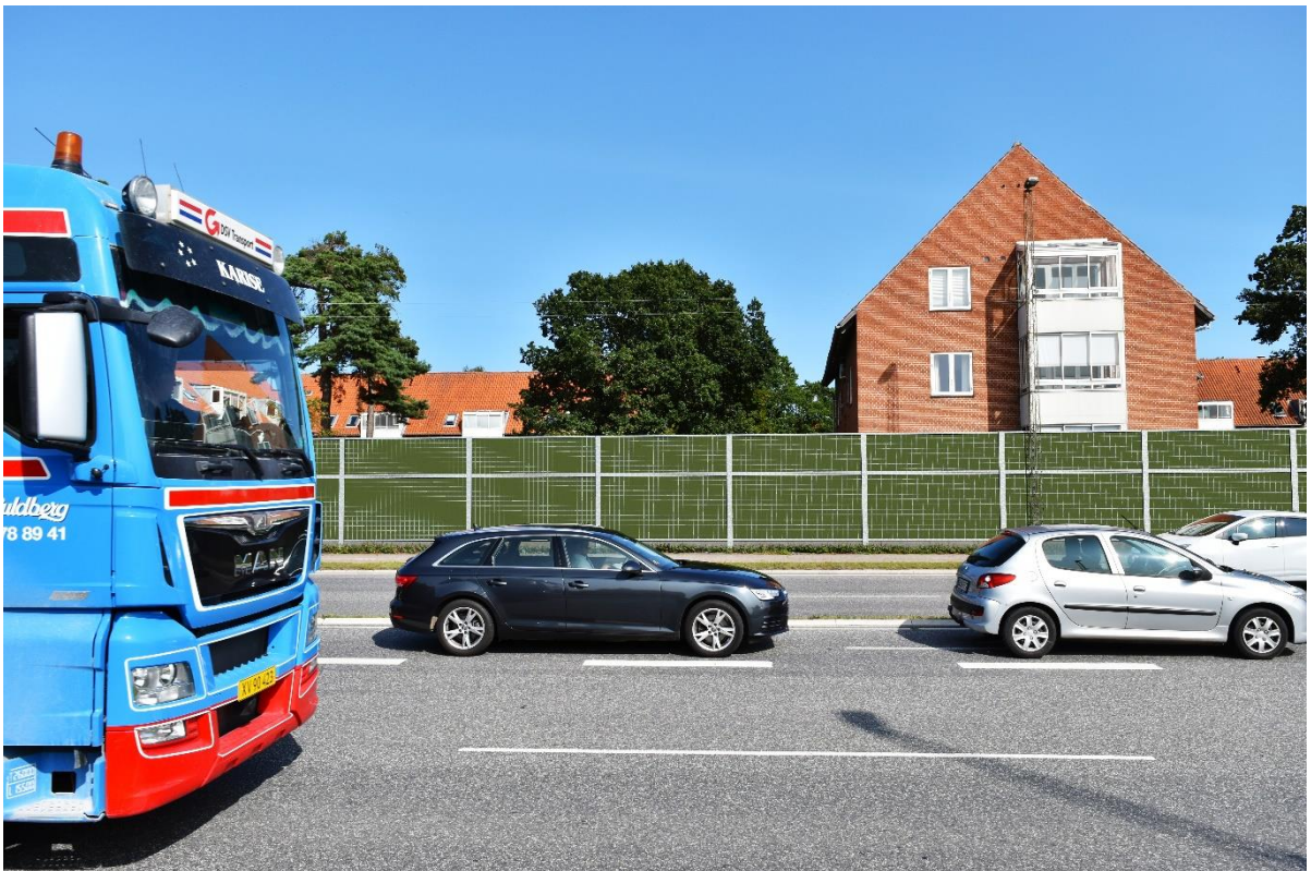
Figur 31: Eksempel på støjskærm ved et etageboligområde. Støjskærmen dæmper støjen på de udendørs opholdsarealer bag skærmen og for boligerne i stueetagen, men ikke for boligerne på 1. og 2. sal.
