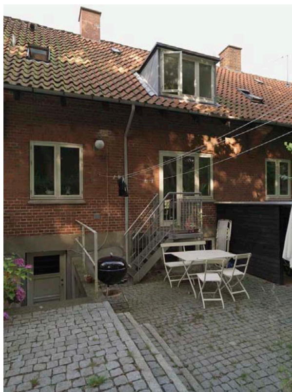
Eksempel på en havedør der er isat, efter huset er opført. Havedørens dimensioner forholder sig til det oprindelige 3-fagsvindue, i overensstemmelse med lokalplanens bestemmelser.
