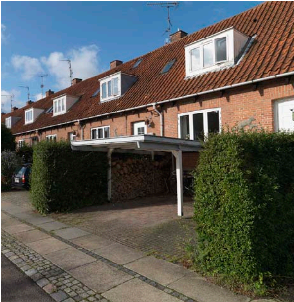
Eksempel på en carport der er i dimensioner og materiale valg er tilpasset bebyggelsen.
