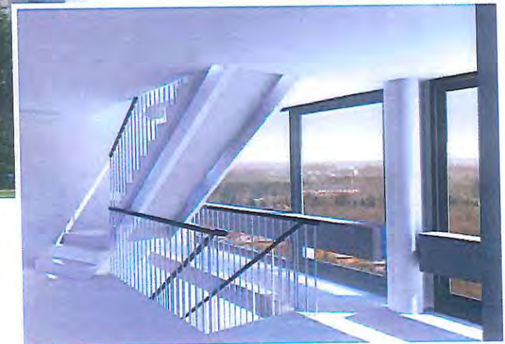
Det nye trapperum med oplukkelige glasinddækning
