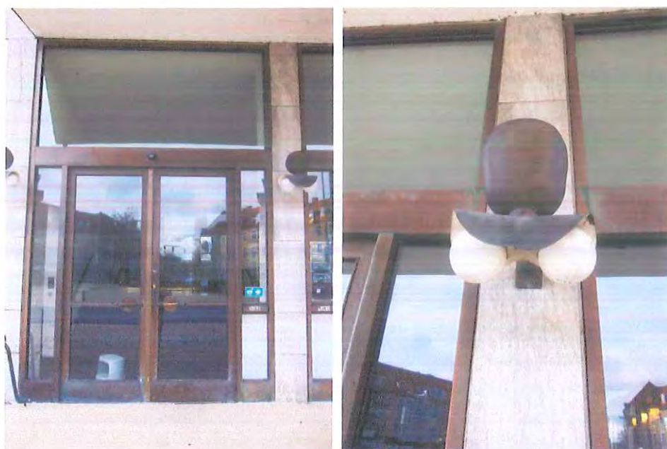
Den ene dobbeltdør samt en af tre oprindelige lamper ved indgangspartiet
