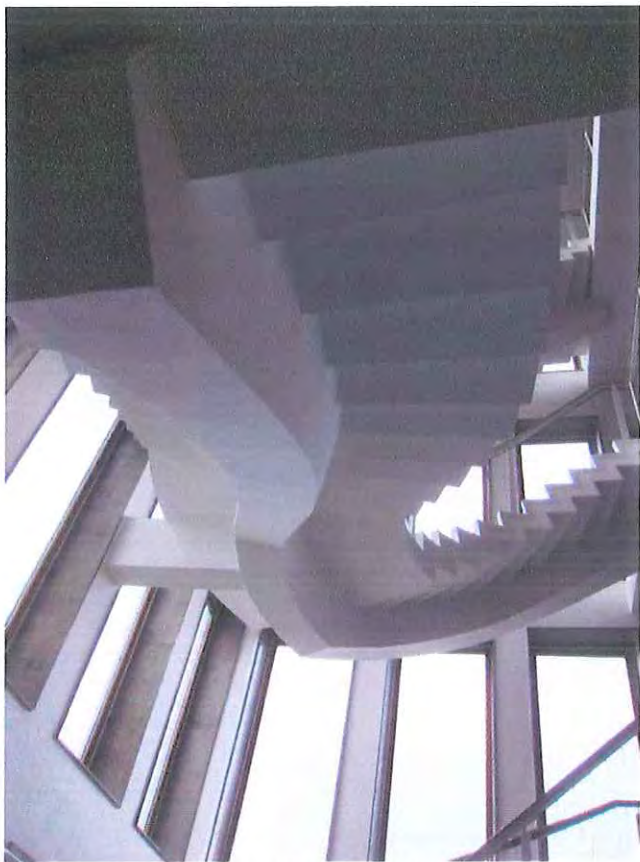
Trappens vedhæftning til betonskelettet
