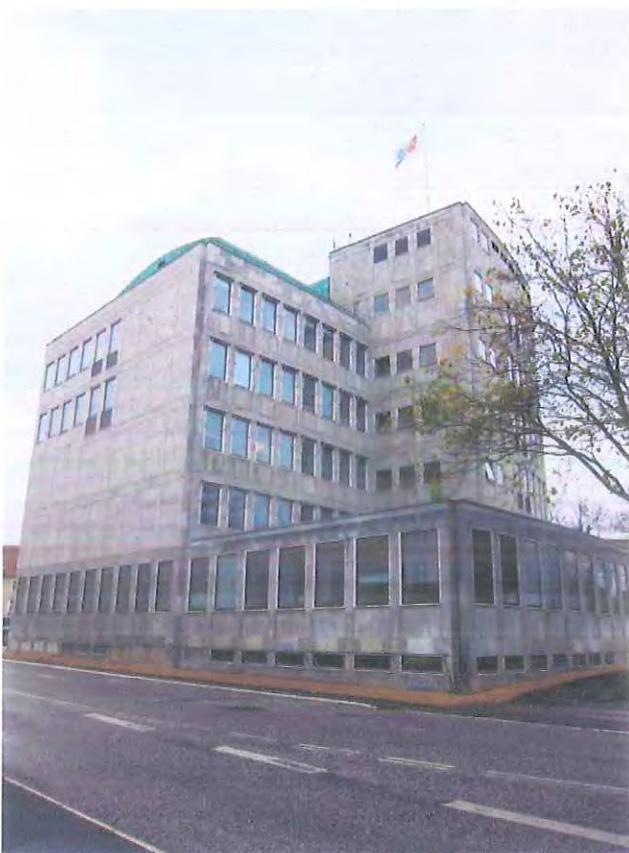
Den tilbyggede længe og trappetårnet
