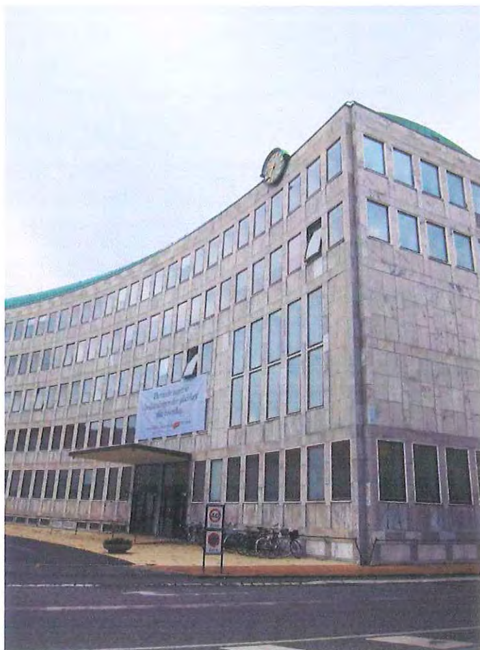
Indgangspartiet med det oprindelige dørparti skærmes af en støbt "kasket". Til højre ses de dobbelthøje vinduer til byrådsalen
