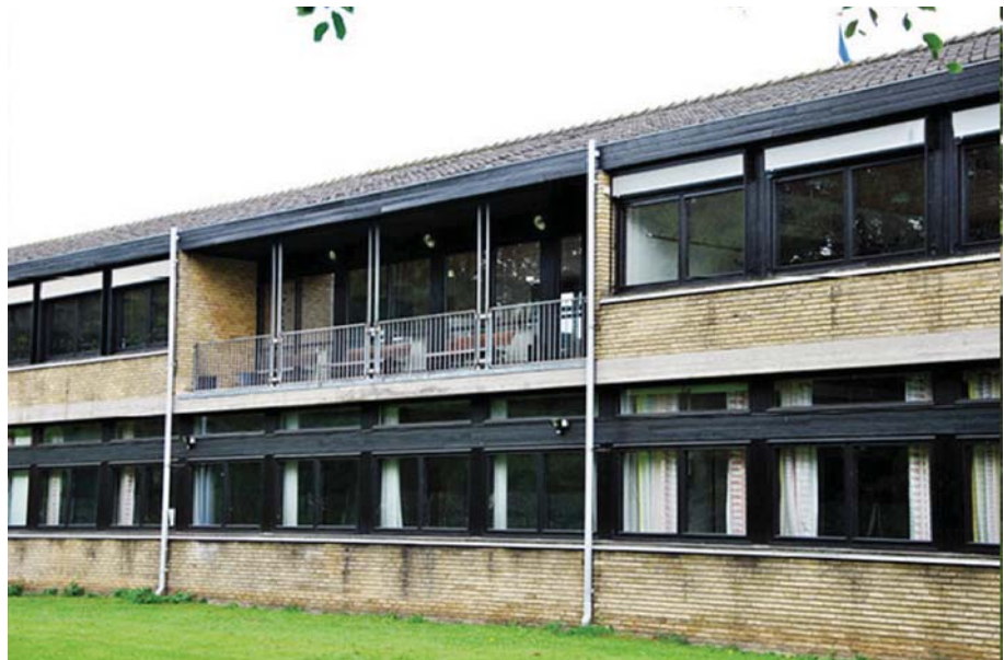
Karakteristisk facade på undervisningsfløj. Fløje i randen af bygningskomplekset er typisk opført i 2 etager, og fremstår med gavle og murflader i gule teglsten. Facaderne er karakteriseret ved horisontale vinduesbånd med sorte karme og rammer.
