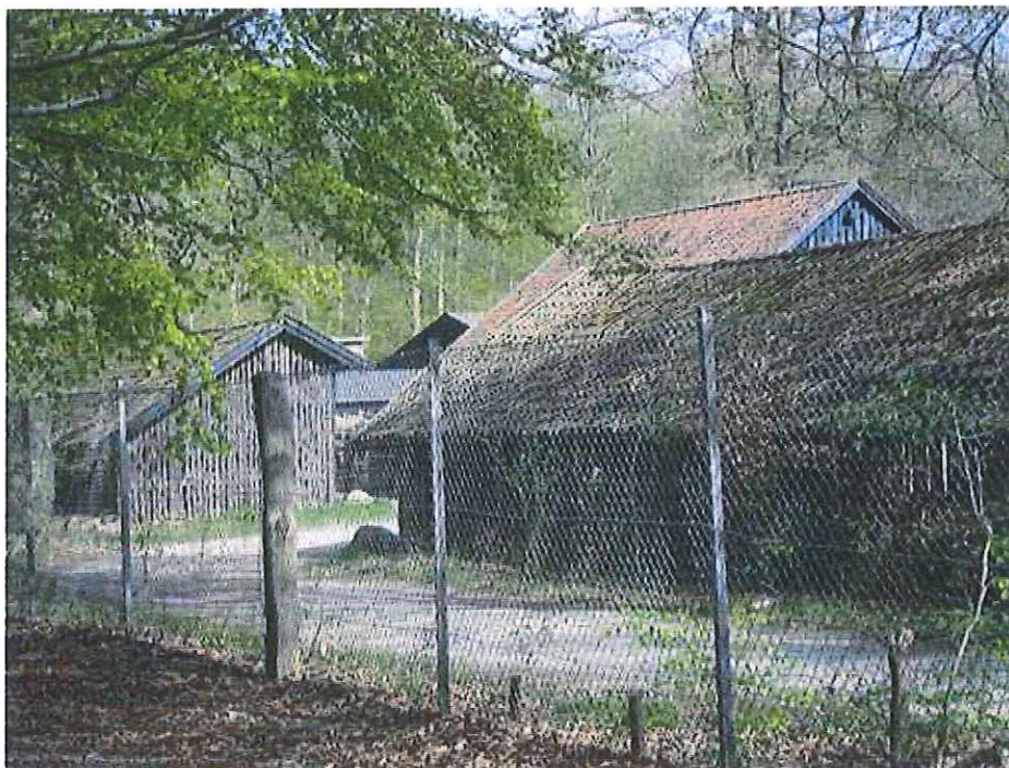
Eksisterende indkørsel mod nord, samt oplagsbygninger, der nedrives til fordel for ny Kaperstald.
