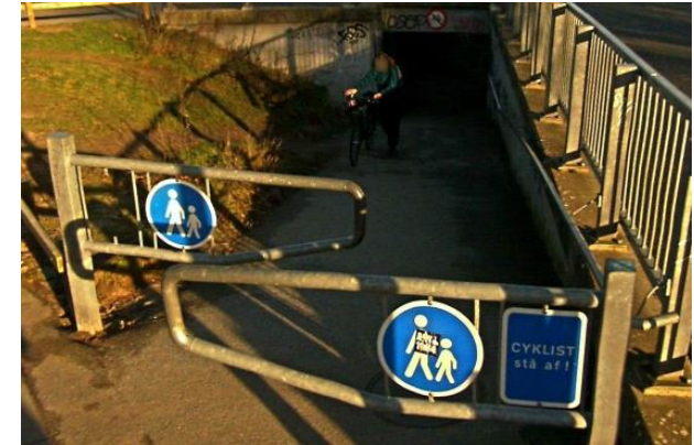
67 Eksisterende nedgang til rottefælden fra Gammel bagsværdvej.
