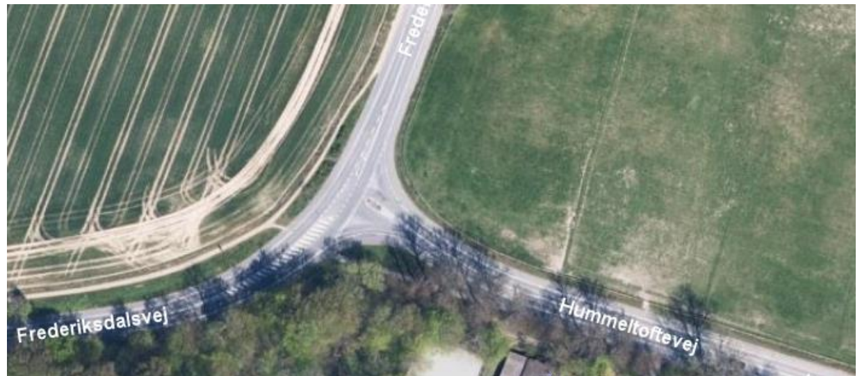
53 Eksisterende forhold i krydset.
