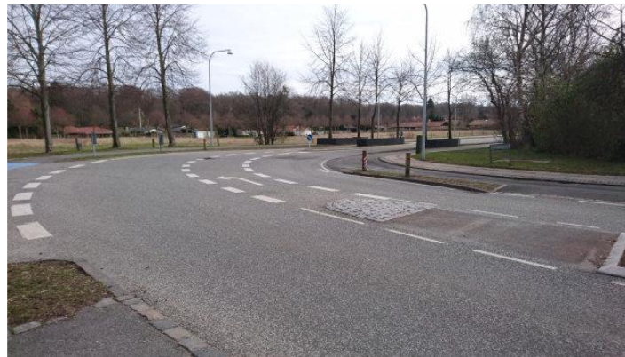
52 Eksisterende forhold i krydset.
