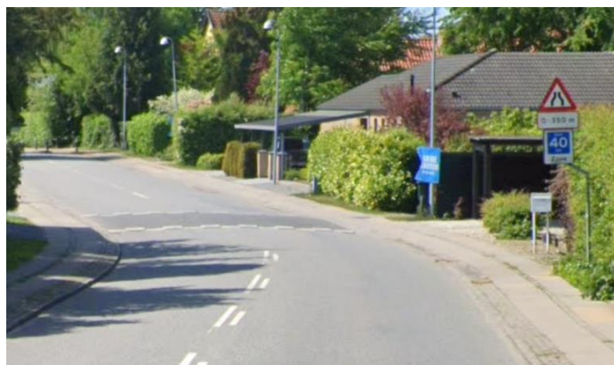
35 Eksisterende forhold på Fuglevadsvej
