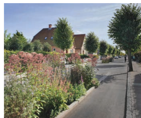
Gasværksvej: Regnvand ledes via åbne vandrender og suppleres af grønne LAR-anlæg.
