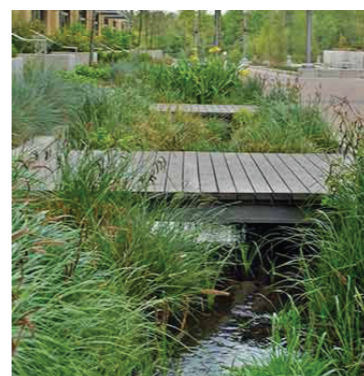
Kastanievej: Den historiske 'Hollandsrende' genetableres, og arealet anvendes til opsamling og forsinkelse af regnvand.
