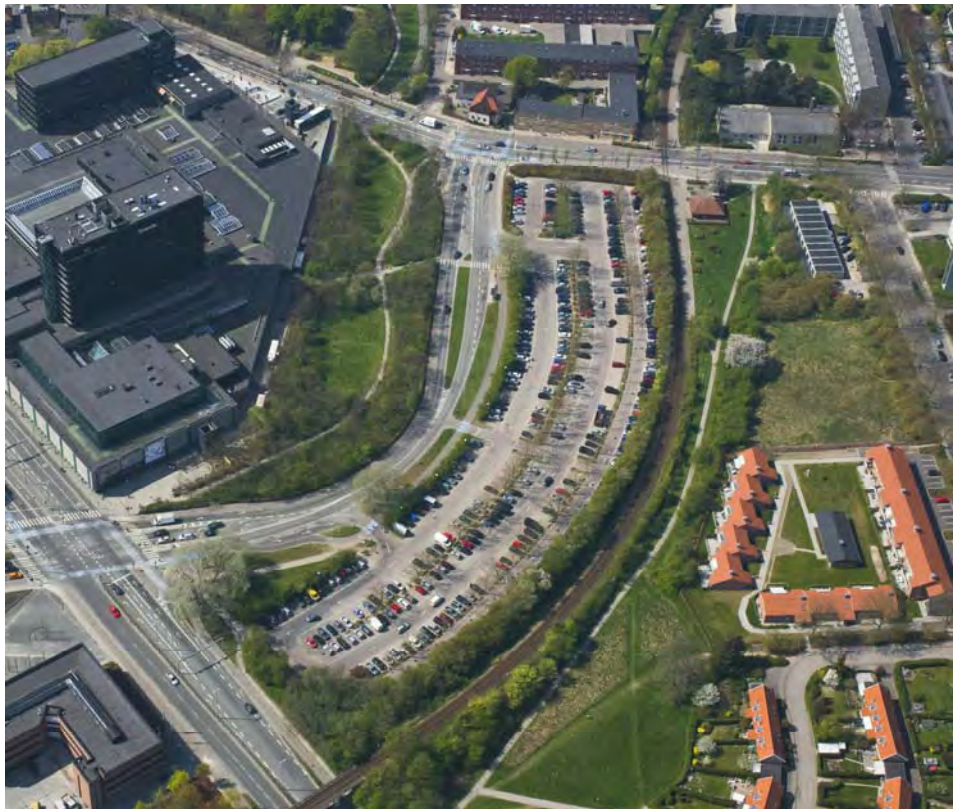
Kanalvejsområdet nord anvendes i dag til offentligt parkeringsareal. Ovenstående illustration viser områdets nuværende anvendelse. Skråfoto © COWI A/S
