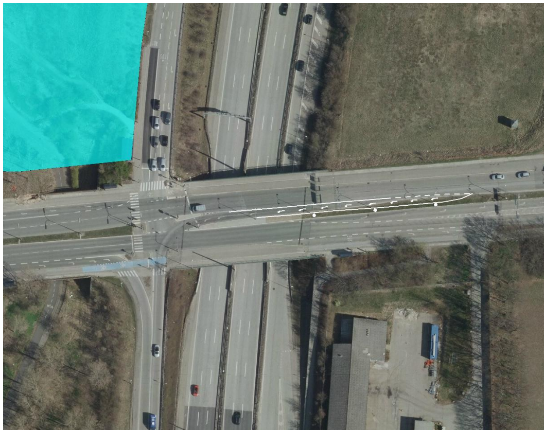
Figur 7: Udvidelse af venstresvingsbane på Klampenborgvej mod Helsingørmotorvejen.
