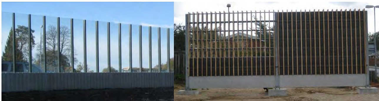
Figur 2 - Lyngbyvejskærm tv. og VD standardskærm th. (vist både som transparent og absorberende).
