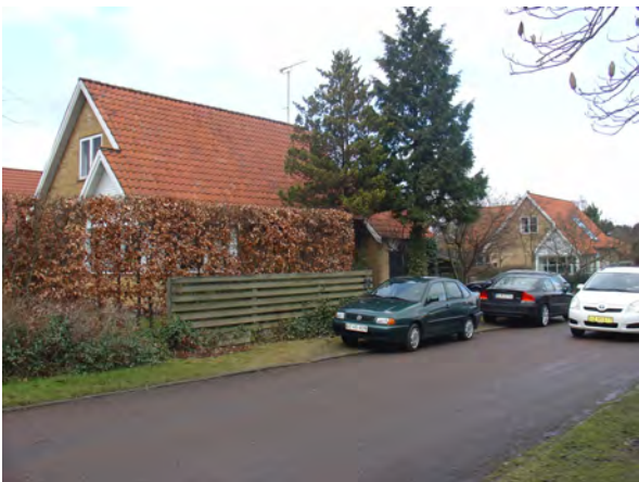
Delområde 5 omfatter den ensartede bebyggelse på Furesøparkvej. Bebyggelsen repræsenterer med sin hustype et håndværkerhus, der er karakteriseret ved at være et halvandenetages hus med tegltag og facader i teglsten.
