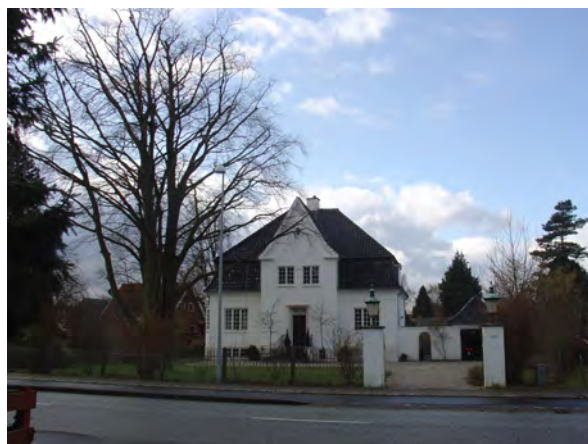
Parcelvej 130 er beliggende i det store villaområde, delområde 10. Villaen fra 1930 udpeges som bevaringsværdig med denne lokalplan, og træet i forgrunden udpeges som bevaringsværdigt.
