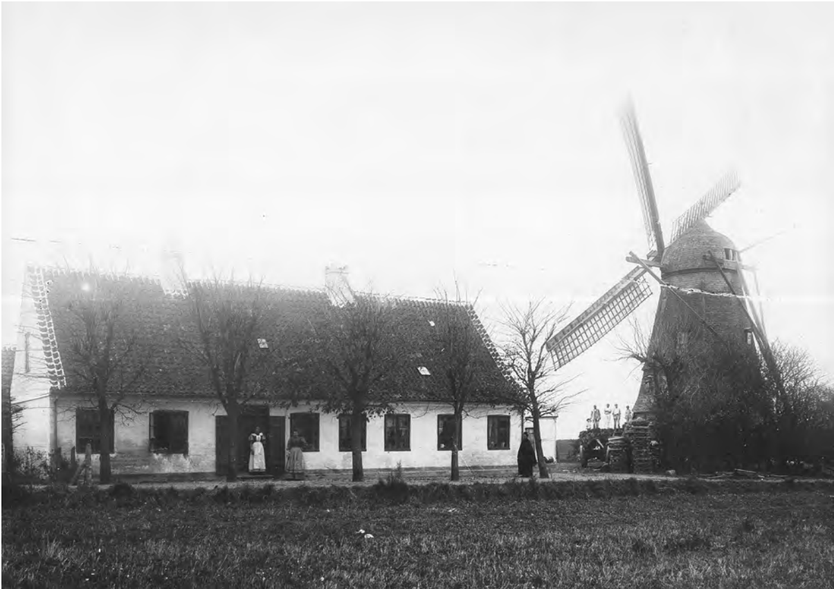
Virum Mølle (Blæsenborg Mølle) og stuehuset i 1890'erne, set fra vest. Vindmøllen brændte i 1913, men stuehuset findes endnu som Virum Møllevej 3. Stuehuset udpeges som bevaringsværdigt i denne lokalplan.
