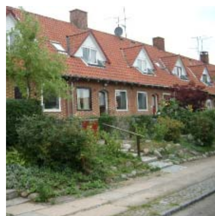
Tornebakken, facadens mønstermurværk
