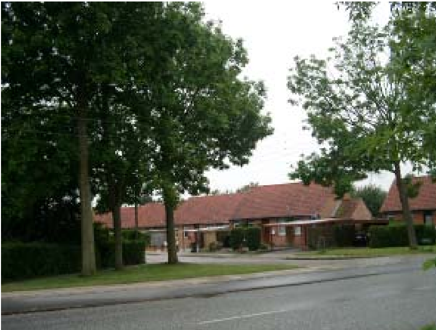
Indkørsel til Hybenvej fra Virumvej
