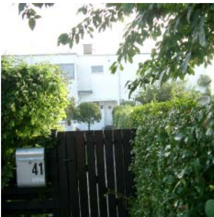
Vestfacade, hjørnevindue og indgangsparti
