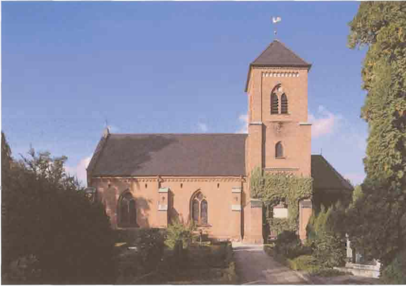
Taarbæk Kirke, også kaldet Skovkapellet, Edelslundsvej 10 (herover), blev opført i 1864 under arkitekt Carl Emil Wessels ledelse. Kirken blev placeret i udkanten af Jægersborg Dyrehave, og først i 1905 blev kirkegården anlagt. Bygningen er opført i røde tegl over granitstenssokkel og består af skib, kor og et tårn, der er placeret op ad sydsiden. Langs nordsiden findes våbenhus og præsteværelse. Kirken er opført i nygotisk stil - efter sigende med forbillede i en gammel angelsaksisk kirke i Limerick. Usædvanligt for en kirke ligger Taarbæk Kirke nærmest skjult i bybilledet, men til gengæld ligger den meget smukt i skoven, lidt væk fra den øvrige bebyggelse.
