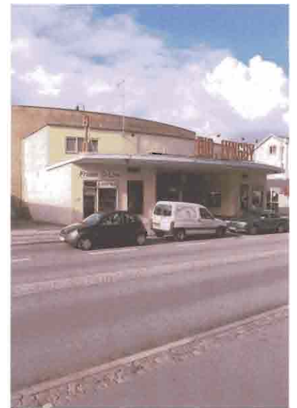
Lyngby Bio, Jernbanevej 8A, blev opført i 1938 af arkitekterne Knud Friderichsen og Arne Poulsen. Bygningen er pudset og malet svagt lysegul, tagene er flade. Gadefacaden er afrappet og svagt rundet med en stor baldakin, der spænder over hele facadens bredde. Indgangspartiet er centralt placeret mellem to fremskudte sidepartier. En markant funktionalistisk bygning, der tydeligt viser sin funktion.
