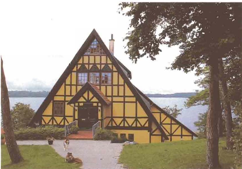
"Flyv fugl flyv", Furesølund 18, blev opført i 1907 ved arkitekt L.W. Rue. Villaen er opført på en stejl skrænt. Mod Furesøen er bygningen i én fuld etage med høj kælder og et stejlt tegltag i 2 etager, på indgangssiden ser man ved ankomst til huset kun de to tagetager. Opført i bindingsværk med smukke dekorationer og udskårne konsolknægte er denne villa helt unik i sit udtryk.
