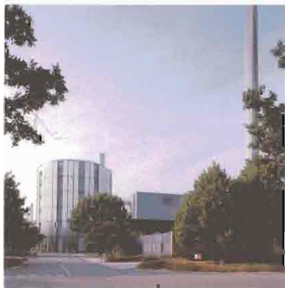
Varmecentral/Kedelhus set mod vest.
