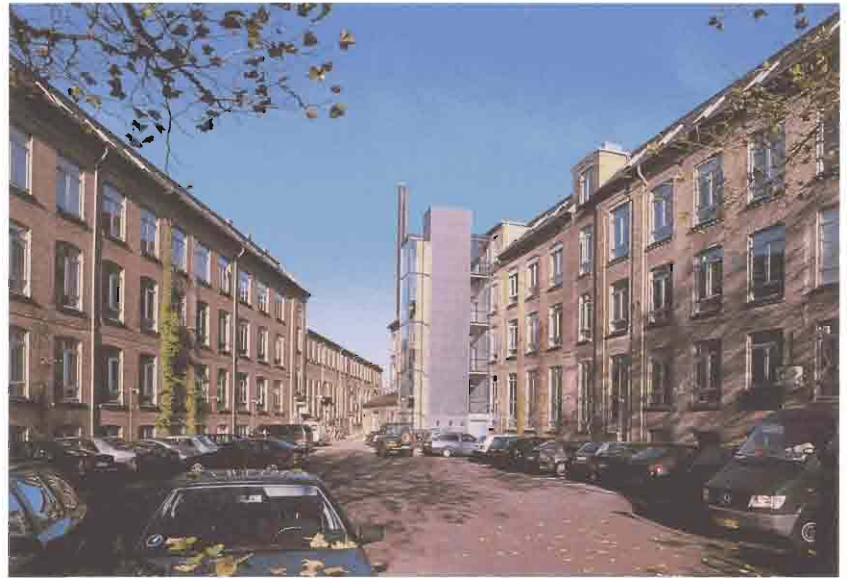
Dansk Gardin og Tekstil Fabrik startede i 1889 i København, men behovet for vand til brug for produktionen fik i 1892 ejeren grosserer Chr. Hasselbalch til at erhverve et stykke jord ved Mølleåen, Gammel Lundtoftevej 1. Her blev de første fabriksbygninger opført 1892-93. I årene herefter blev fabrikken udvidet i flere omgange, og anlægget af gule industribygninger i en til fem etager ligger smukt ned til åen. Fabriksanlægget huser i dag en række mindre virksomheder.
