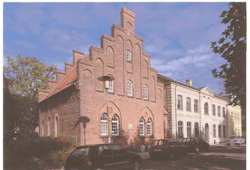
Den gamle inspektør- og skolebygning, Høstvej 1. Bygningen til højre er ældst, opført i 1882/1895 i gule sten med skifer på taget af arkitekt og murermeister Suhr. Facaden er symmetrisk udformet omkring en smal midtrisalit med trekantfronton og indgangsparti, og udsmykket med mønstermuret gesims og kvadernurede hjørnemarkeringer. Bygningen til venstre blev opført i 1904 som inspektørbolig efter tegninger af arkitekt Harald-Lønborg Jensen. Et grundmuret gavllhus i røde tegl over en kampestenssokkel. Gavlene, der er gotisk inspireret, afsluttes med kamtakker og har spidsbuede blændinger og vinduesindfatninger. Trods to forskellige stilarter spiller de to bygninger pænt sammen.
