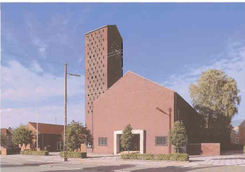
Christianskirken, Christian X's Allé 120, blev opført i 1940-41 efter tegning af arkitekterne Erik Jensen og Jacob E. Bang. Kirken er opført med et nord-sydvendt langhus i røde teglsten og med saddeltag, et tårn mod vest og en lille udbygning mod øst. Kirken er udformet i moderne stil med enkle dør- og vinduesindfatninger, og er ellers fuldstændig renset for overflødige detaljer. Tårnet er opført med murdekorationer. En flot og markant moderne kirke.
