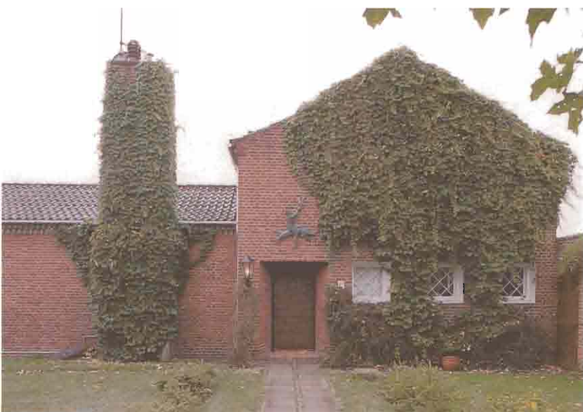
I.H. Mundts Vej 10A (1934) er en rødstensvilla med grønt tegtag, tegnet af arkitekt Edwin Christiansen. Et velkomponeret bygningsvolumen bestående af to længer i forskellig højde placeret vinkelret på hinanden. Gavlen på den højeste længe er mest iøjnefaldende, her er indgangen smykket med et relief, og vinduerne er udført med diagonalsprosser.
