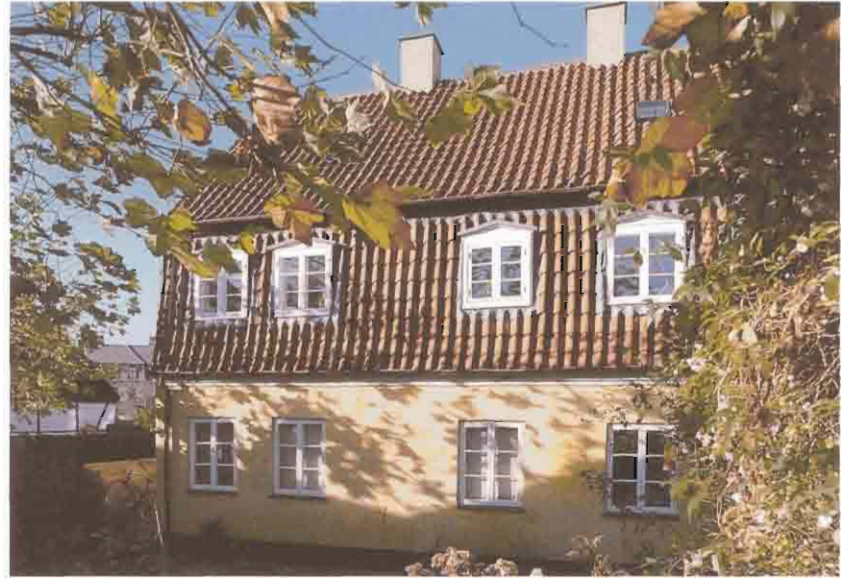
Asylgade 17 (1922) er en lille grundmuret bygning med et stort mansardtag. Murene er pudsede og gulkalkede, og der er røde tegl på taget. Bygningen passer størrelsesmæssigt fint i Bondebyen, på trods af at taget, med mansard og stejl hældning, virker temmelig dominerende.
