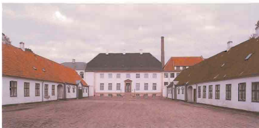
Brede Hovedbygning set mod nord.
