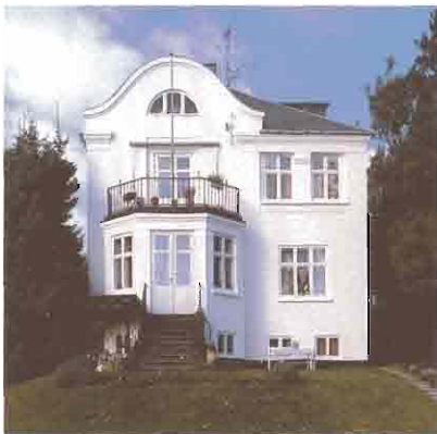
Taarbækdalsvej 4-14 er en række typehuse, opført omkring 1912 af arkitekt J. Therschilsen. Husene er bygget i to etager med pudsede mure og skifer på de afvalmede tage. Alle husene har let fremskudte facadepartier med fronkviste, karnapper og balkoner, varieret udformet fra hus til hus.
