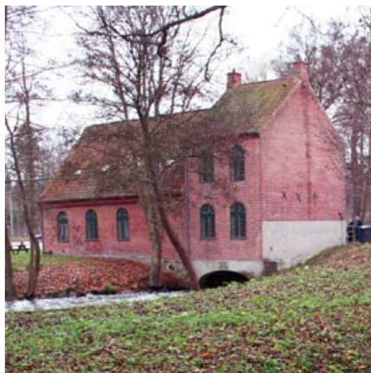
Mølle og turbinebygningen Foto: Morten Stenak
