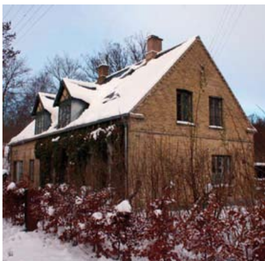
Arbejderboligerne ved Fuglevad er opført i 1901. Foto: Arne Høi
