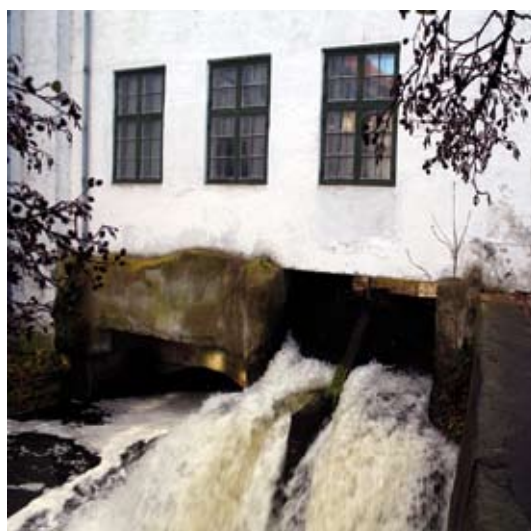
Udløbet i turbinekanalen. Til venstre ses turbinekammeret med den grove pudning og rundbuede munding. Til højre fosser vandet gennem to kamre, hvor "frivandet" styres af stemmeplanker – det er her selve Mølleåens vand afvikles. Foto: Morten Stenak
