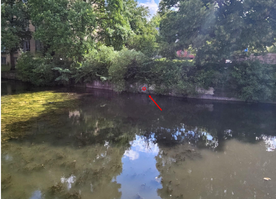
Figur 4-4. Mølleåen med betonbrink i baggrunden og angivelse af udløbspunkt (rød cirkel).
