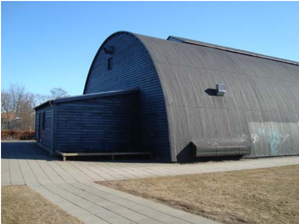
Engelsborghallen set fra vest. Den gamle badmintonhal med tagpapbeklædning og brædebeklædt gavl.
