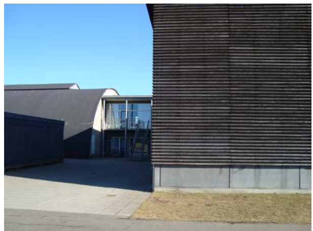
Hallerne set fra sydvest. I forgrunden til højre Bauehallen med listebeklædning og i baggrunden den gamle badmintonhal (Engelsborghallen) med tagpapebeklædning. I midten ses en del af fritidsklubbens glasfacade.
