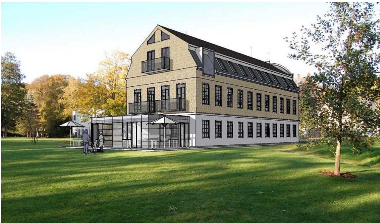
Pritzels fabriksbygning set fra parken. Bygningen skal stå på en flade, hvilket opnås ved etablering af en fast belægning rund om huset.
