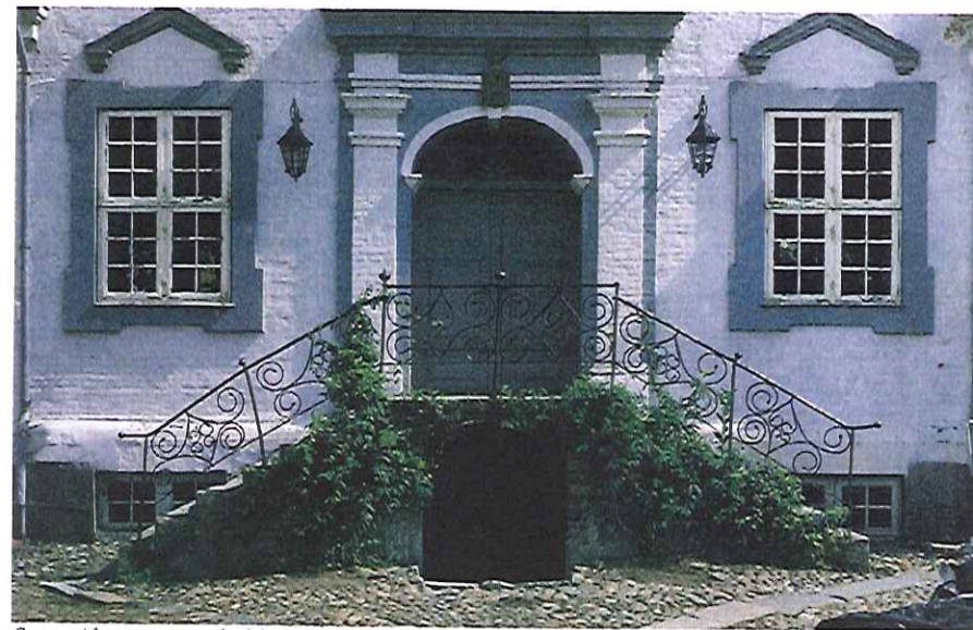
Symmetrisk repostrappe med to løb og kældernedgang anbragt i midten samt fint smedejernsgelænder. Et smukt samspil mellem bygning, trappe og gårdspladsens belegning. Foto: Erik Einar Holm
