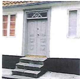
Helt enkel trappetype med ganske få stigninger. Opbygget alene af granittrin og uden gelænder. Foto: Erik Einar Holm
