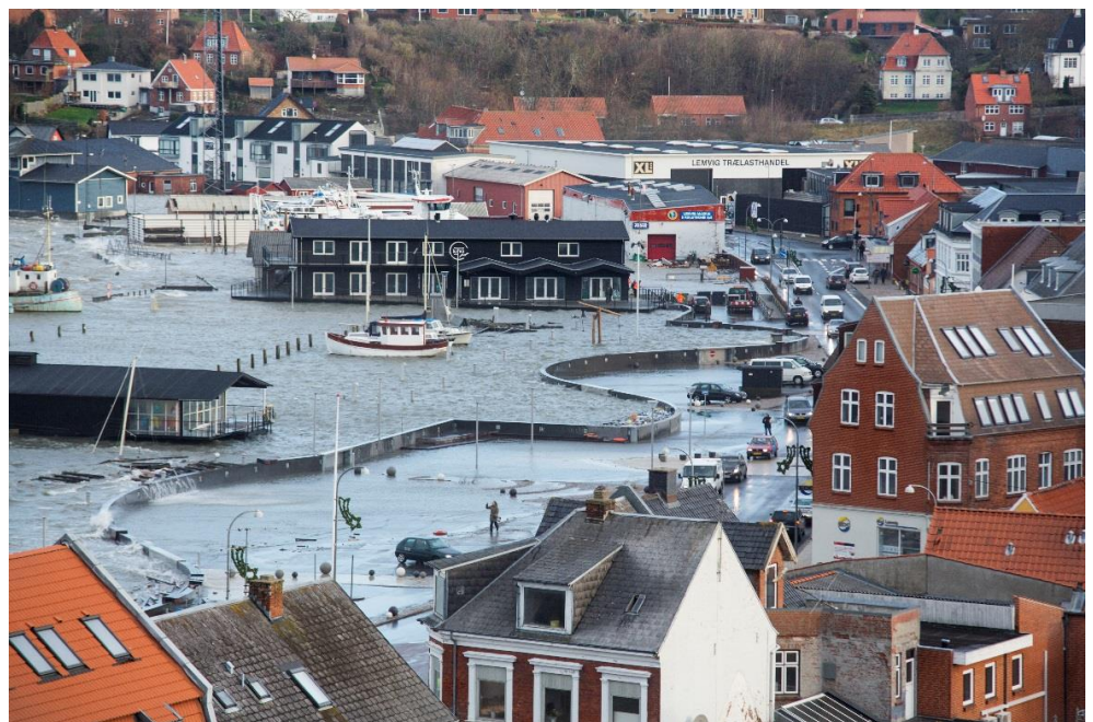
Figur 3-1 Stormflodssikring i Lemvig.
