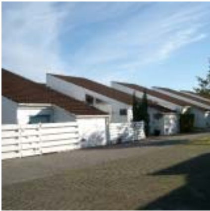
Dahliahaven, kædehuse set mod øst
