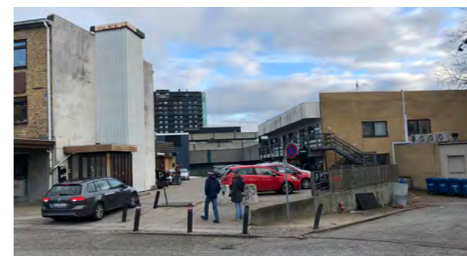
Bagside på Gasværksvej
