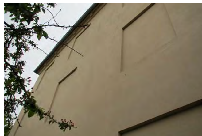
Blænding på gavl som ikke genskabes
