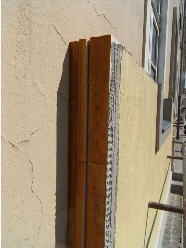
Opbygning af efterisolering
