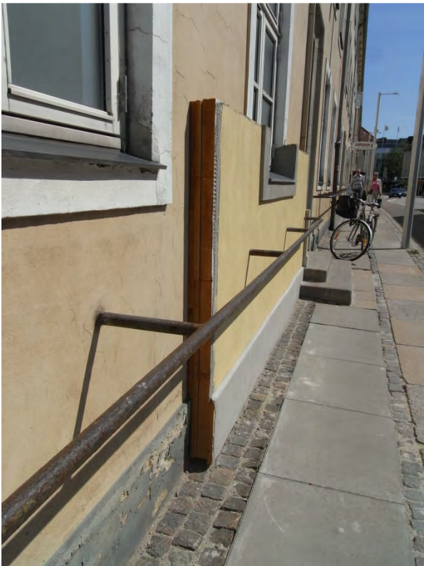
Udvendig efterisolering af sokkel helt til terræn. Ved endelig udformning er det vist i tegningsmaterialet, at efterisolering fortsætter ned i jorden.
