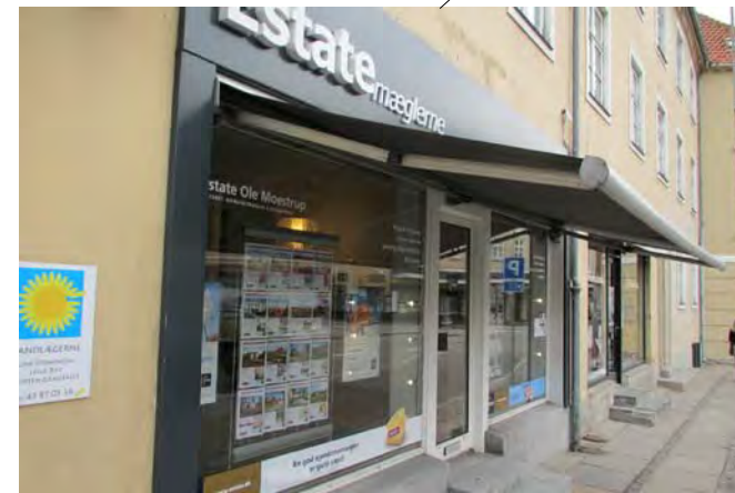
Eksisterende butiksvinduer rykkes ikke frem i facadeisolering
