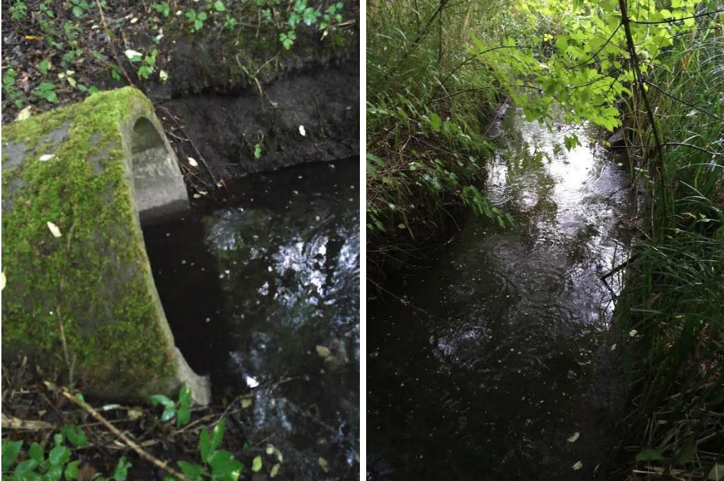
Figur 7 Til venstre ses udløb fra underløb under stien. Til højre ses set videre forløb gennem mosen.
