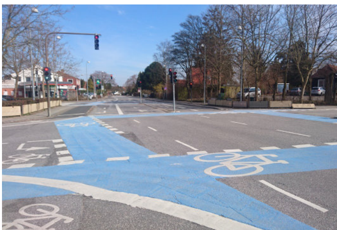
Billede af eksisterende forhold
