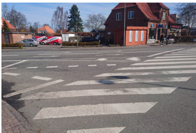
Billede af eksisterende forhold
