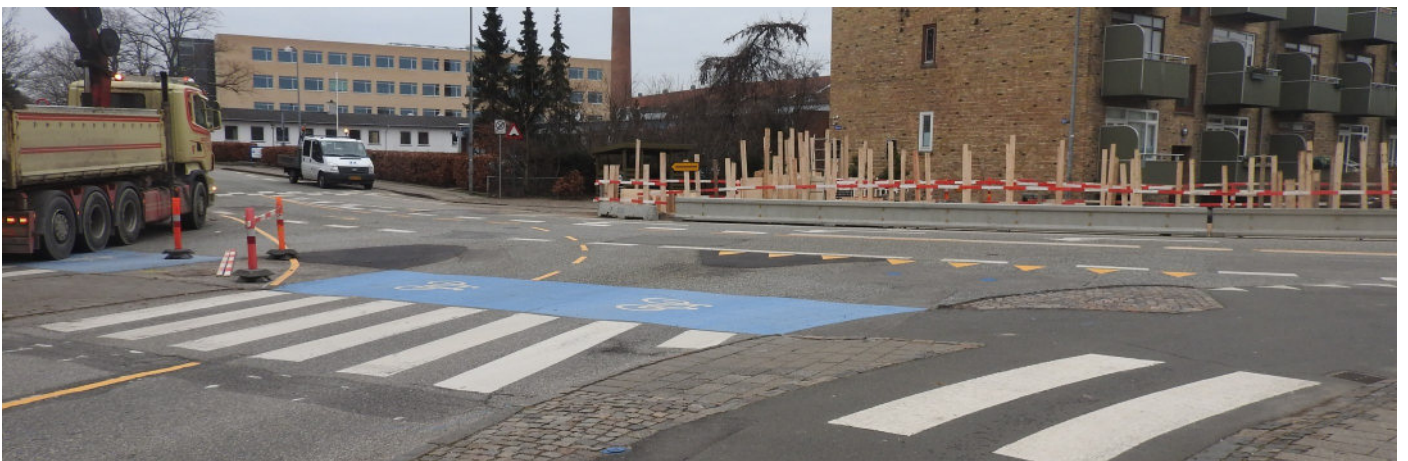
Billede af eksisterende forhold
