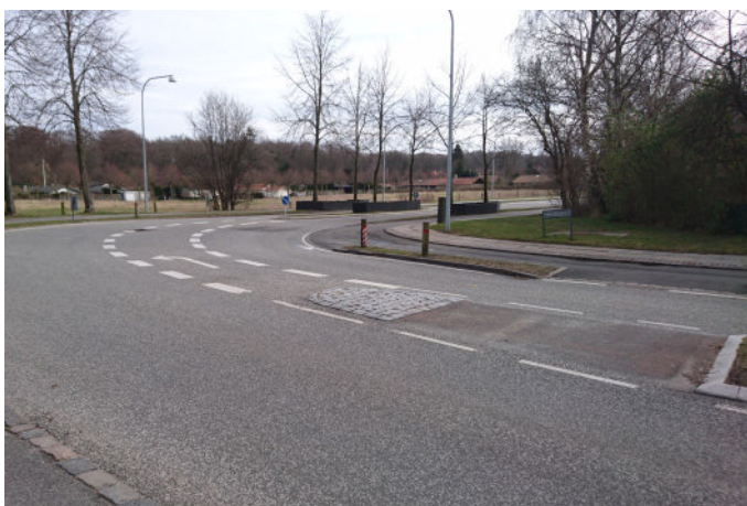
Billede af eksisterende forhold
