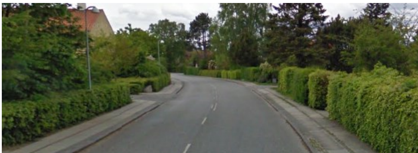
Billede af eksisterende forhold
