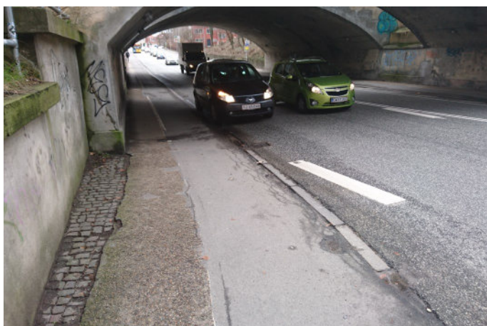
Billede af eksisterende forhold
