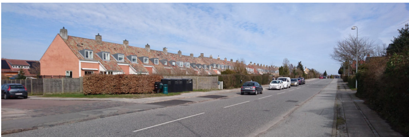
Billede af eksisterende forhold
