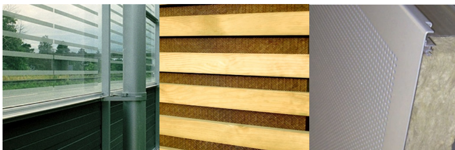
Figur 4 Eksempler på støjskærme: (til venstre) transparent og reflekterende; (i midten) absorberende med træbeklædning; (til højre) absorberende med perforeret metalplade.
