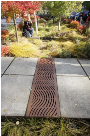
Foto 2: Vandet fra de 3 småveje samles ved indkørslen i et linjedræn, der leder det til nedsivning.
