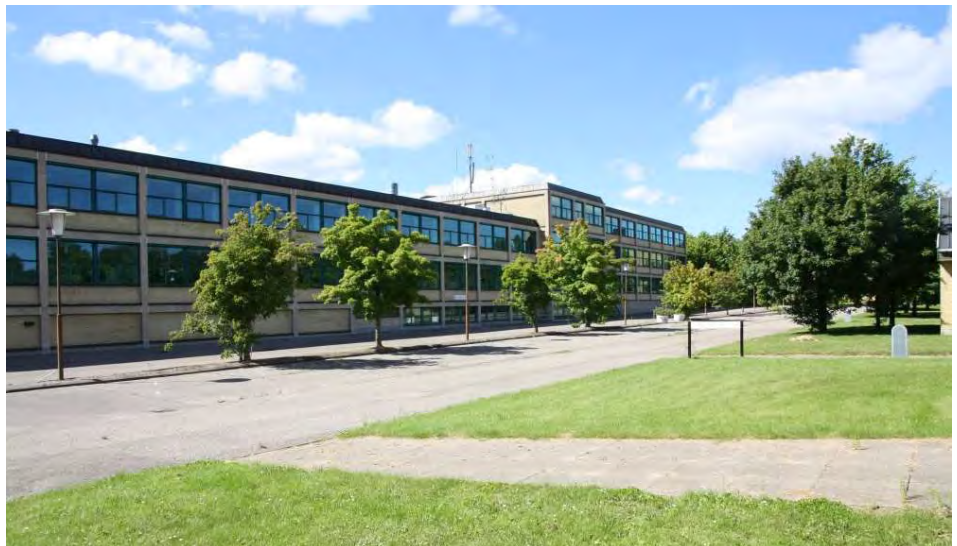
De eksisterede bygninger centralt i området.
