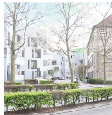
Nye, lyse boliger på Gasværksvej
