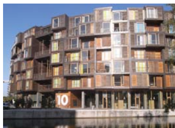
Nye boliger for studerende, gæstelærere og familier - Tietgens Kollegie på Amager
