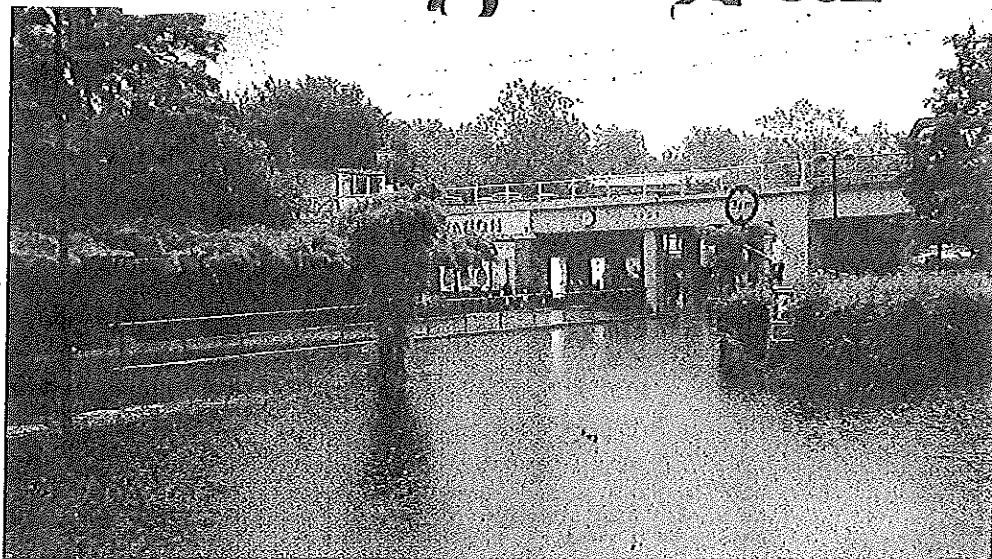
Skybruddet satte viadukten ved Virum Station under vand.
