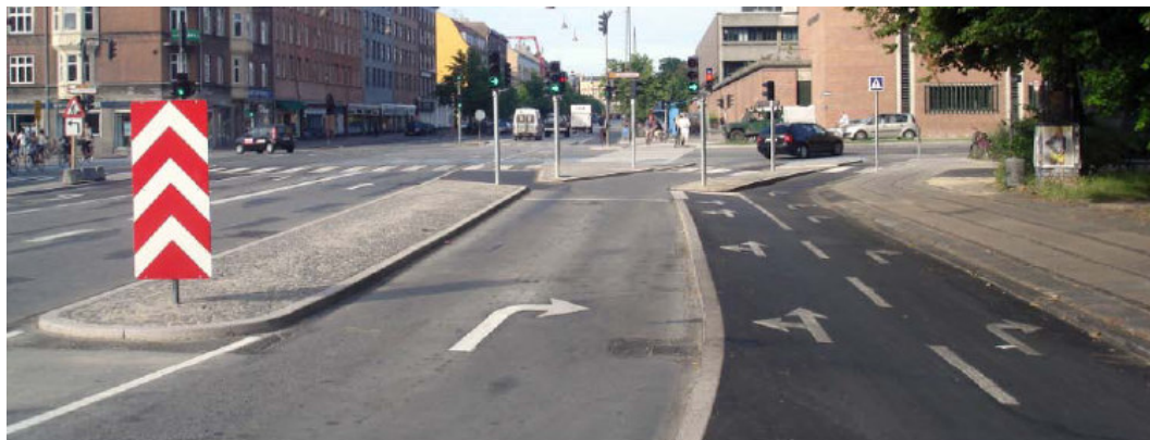
Figur 10. Højresving med separat regulering af ligeudkørende og højresvingende cyklister via cykelshunt. (Byernes trafikarealer - Hæfte 4 - Vejkryds)
