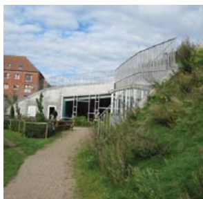
Byggeri med græs på taget - Korsgadehallen i København
