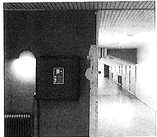
Prøve S20: Blå maling ved slangevinde, stuegang, Resultat: 1200 mg/kg
