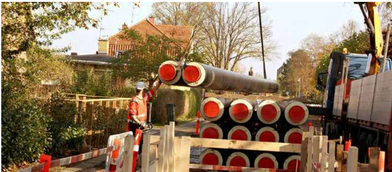
Foto: Fjernvarmearbejde i Lyngby, www.vestfor.dk/Fjernvarme/Fjernvarmeprojekter/Lyngby_1
