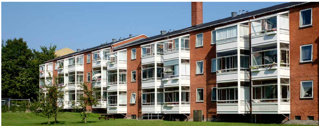
AB Toftevang har gennemført efterisolering af hultmure og loftsisolering, samt omstillet deres vaskeri til varmtvandsdrift, og sparer nu 37.000 kr om året i energiudgifter. Foto: Morten Kjærgaard, Energitjenesten
