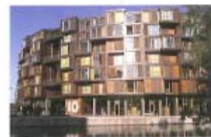
Nye boliger for studerende, gæstelærere og familier - Tietgens Kollegie på Amager
