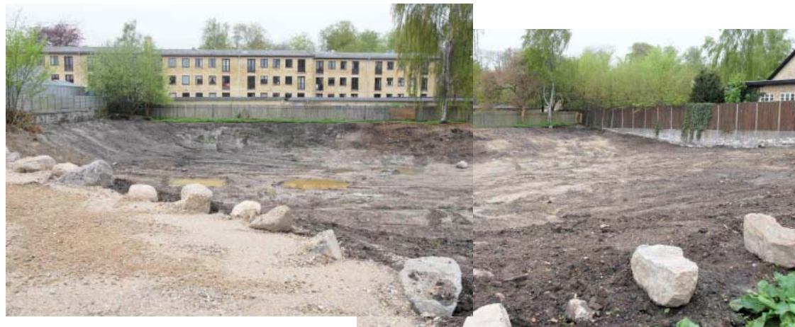
Reg. foto: Udgravning efter nedrivning af erhvervsejendom
