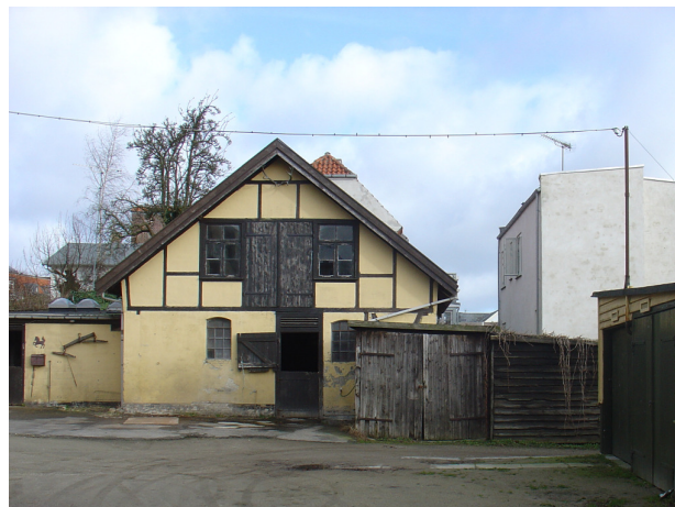
Staldbygningen i 1½ etage forudsættes nedrevet.
