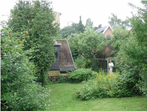
Grunden er skrånende ca. 3 m fra det nordvestlige hjørne ned mod bebyggelsen. En del af dette areal bevares som fælles haveareal.
