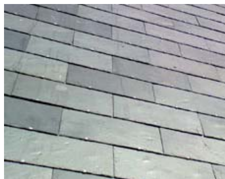
Facademateriale med stofflighed og variation
