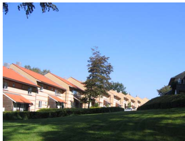
Etageboligerne på Gyvelholm er fra 1997. Bebyggelsen fremtræder i gule teglsten med vandrette røde murstensbånd og rødt tegltag.
