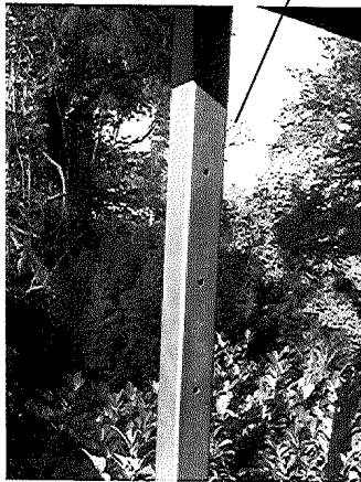
Bærende stolper i galvaniseret stål
