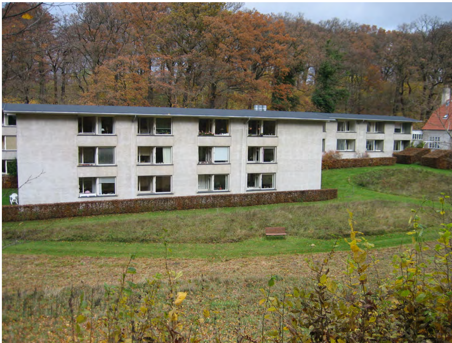
Facade mod syd bygning C og D
