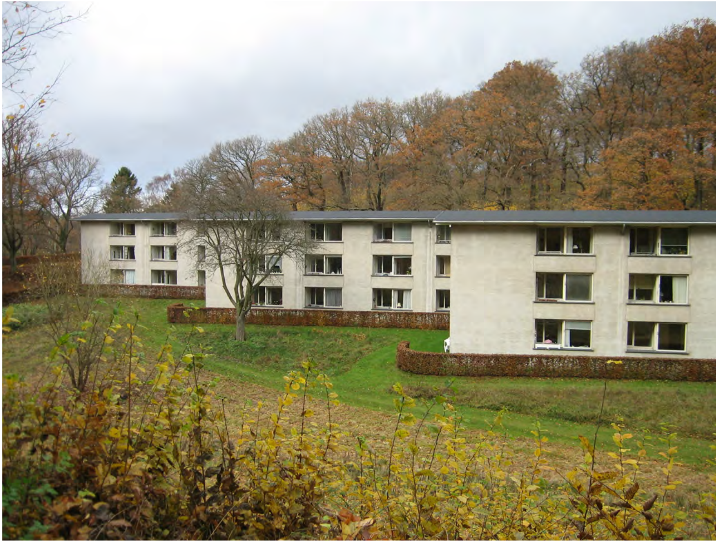
Facade mod syd bygning A, B og C
