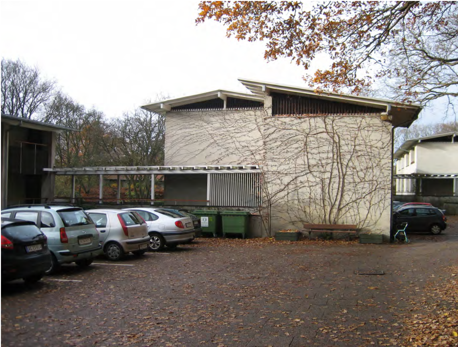
Facade mod øst bygning B
