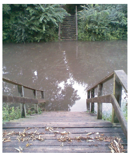
Fæstningskanalen: Oversvømmelse ved den tidligere "Ligbærerbro".
