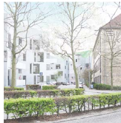
Nye, lyse boliger på Gasværksvej
