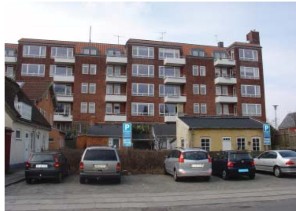
Eksempel på blandingen af meget høje bygninger og lave huse. Den lave bebyggelse i delområde 3 ses i forgrunden og etageboligerne i delområde 9 ses i baggrunden.
