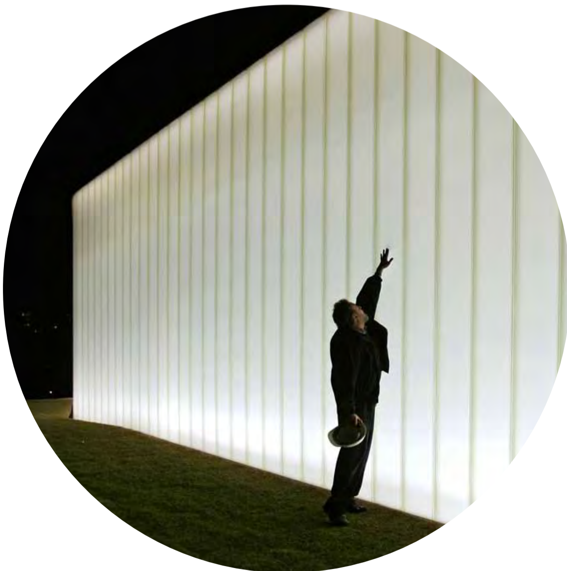
Facaden; lys, refleksion og kommunikation
