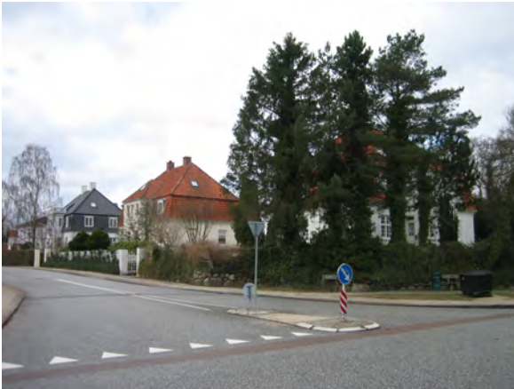
Delområde 3 omfatter de tre palæagtige villaer på Højdevej. Villaerne er markante i bybilledet.
