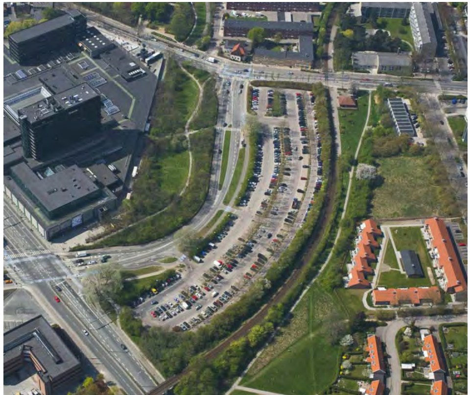
Kanalvejsområdet nord anvendes i dag til offentligt parkeringsareal. Ovenstående illustration viser områdets nuværende anvendelse. Skråfoto © COWI A/S
